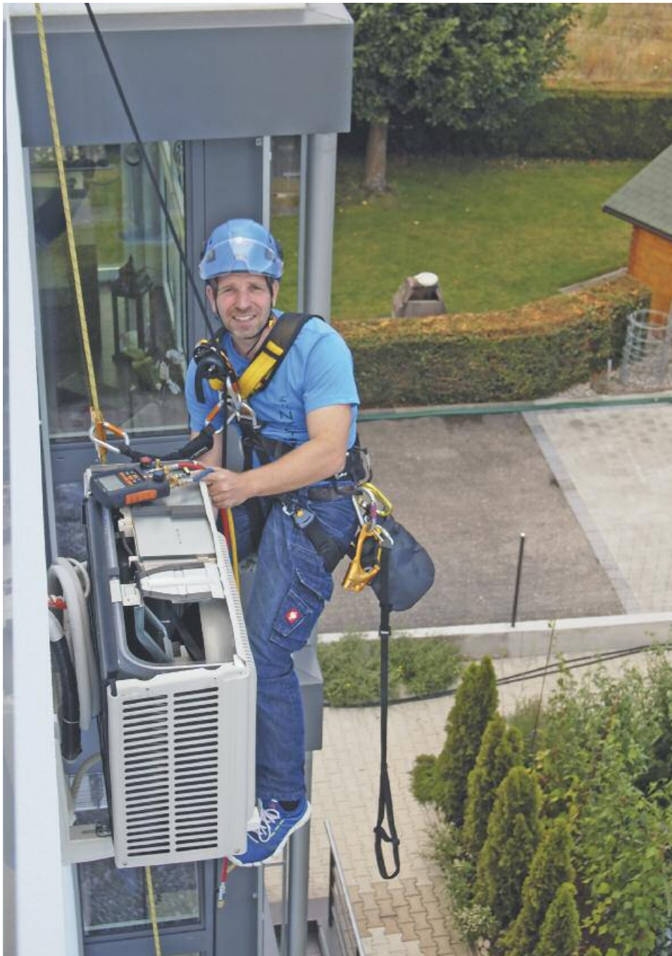
Zwei Leidenschaften vereint: Michael Wirz beim Hochseil-Service an einem schwer zugänglichen Klimagerät.
